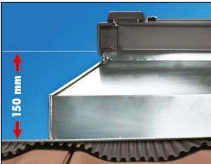
Oft werden in schneereichen Regionen Fertigelemente eingesetzt, wobei deren Höhe vom ortsansässigen Kunden selber bestimmt werden kann. Der Eindeckrahmen wird dann von einem Spengler hergestellt.
