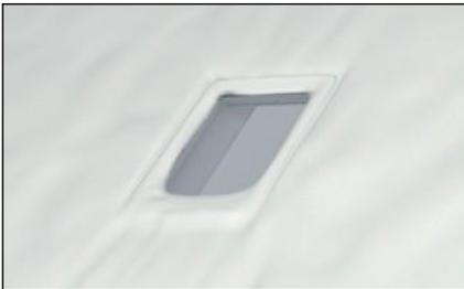
Dadurch schmilzt der Schnee auf einem Dachfenster selbst mit einem sehr guten Isolierglas schneller als auf der übrigen Dachfläche. Je grösser die Temperaturdifferenz, umso schneller gefriert das Wasser unterhalb des Dachfensters auch wieder.
