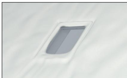
C'est ainsi que la neige fond plus rapidement sur une fenêtre de toit, même munie d'un très bon vitrage isolant que sur le reste de la surface du toit. Plus la différence de température est grande, plus vite l'eau va regeler en dessous de la fenêtre de toit.
