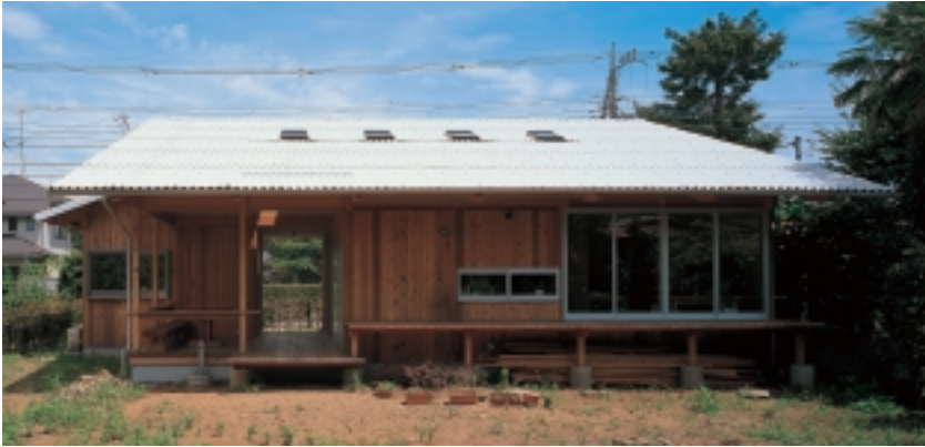
小さめのルーフウィンドウは点々と並べてやるとリズムカルな内部空間が出現する。点窓と呼ぶべきか。
