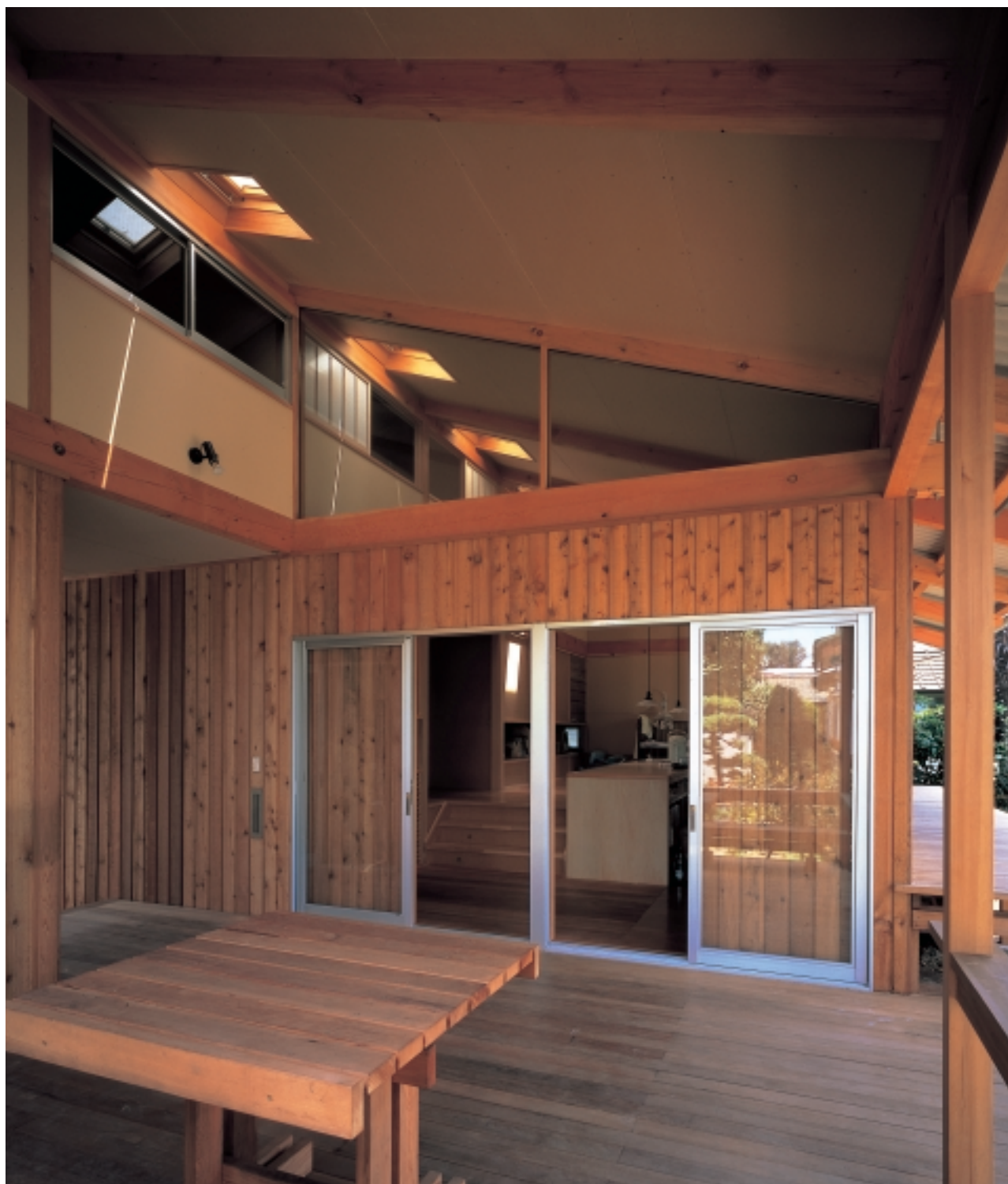
吹き抜けに取り付いたルーフウィンドウは上下の温度差を利用して効率よく自然換気が行なえる。
