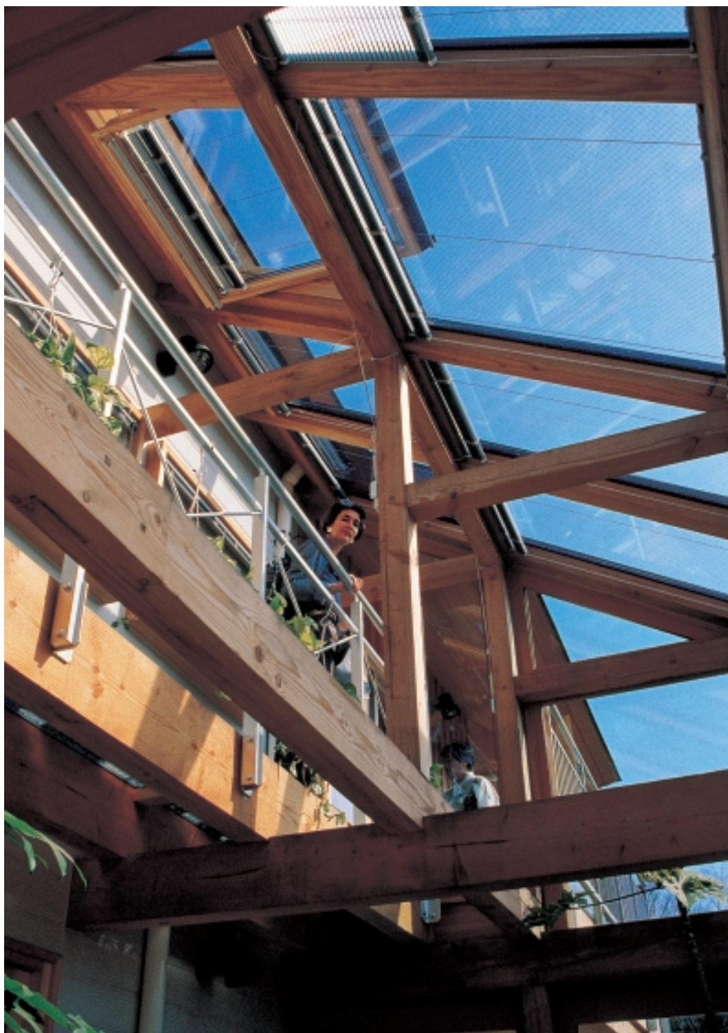
「ちぎゅうむらの家」(北九州市) 温室内部見上げ。
