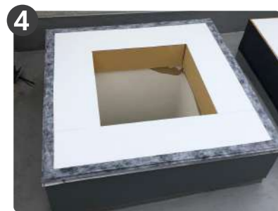
架台の化粧と側部の板金加工、水返しアダプターを設置
