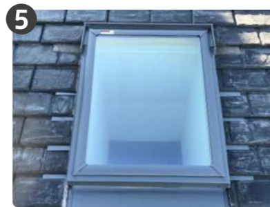
水切りを設置し屋根材を戻して完成
