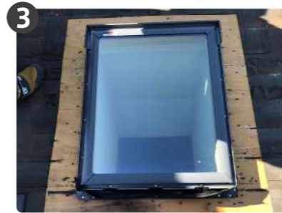
見切り材を設置後に天窗設置
