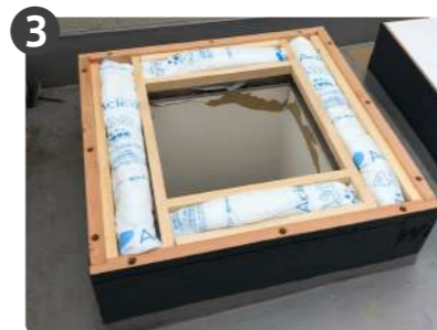
架台内に結露防止の断熱材充填
