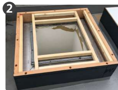
天窗を設置する架台作成、側部に専用防水シートを設置
