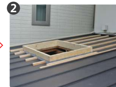
屋根に開口して枠キット設置し、ステージ作成
