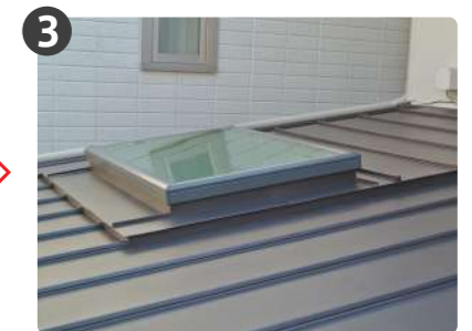
ステージに屋根材を葺き、FCMを設置して完成
