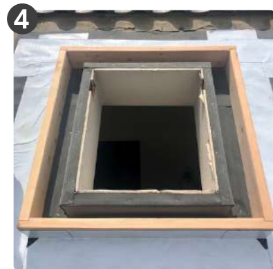
FCM枠キットと専用防水シート設置
