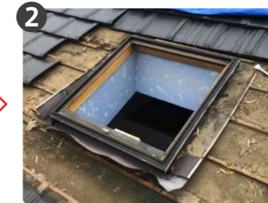
天窗周辺の屋根材を撤去
