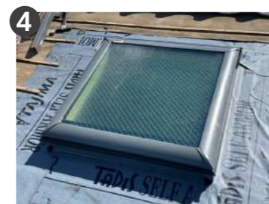
天窗設置後に専用防水シートを設置
