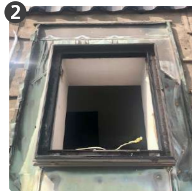
天窗周辺の屋根材とガラスユニットのみ撤去(本体枠は残す)
