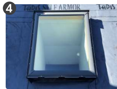
専用防水シートを設置
