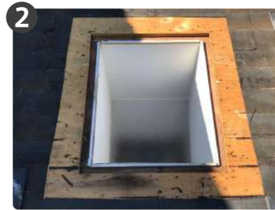
天窗周辺の屋根材と天窗を撤去
