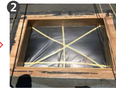
天窗周辺の屋根材と天窗を撤去
