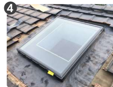
見切り材を設置した後にひと回り大きなサイズの天窗を設置、専用防水シート設置
