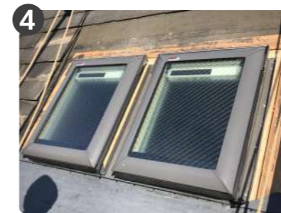
天窗を設置して専用防水シート設置
