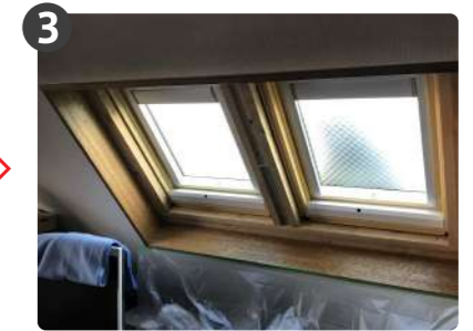
開口の真ん中に補強垂木工事
