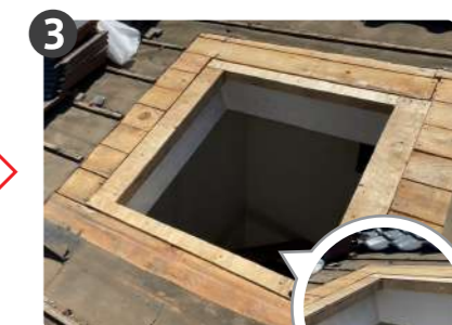
天窗撤去し、野地開口を調整
