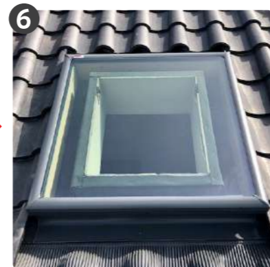
屋根材を戻して、FCMを設置して完了
