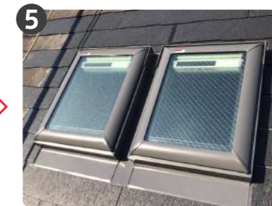
水切りを設置し、屋根材を戻して完成
