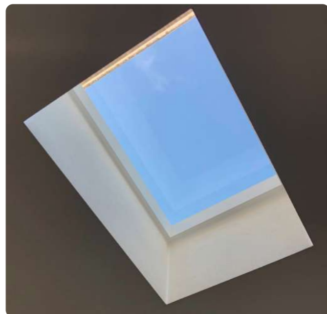
見切り材を設置後の完成内観
