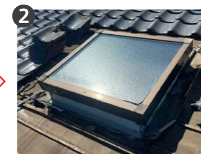
天窗周辺の屋根材を撤去
