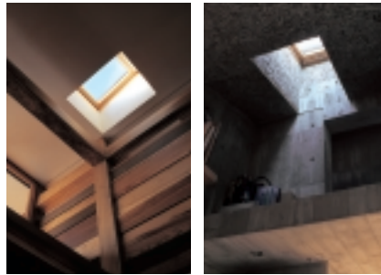
左: 内4から見上げた天窓。この天窓を潜水艦のハッチのように開けて顔を出す、屋根にもアプローチが可能 右: 内6から見上げた天窓。コンクリート棟最上階の個室
