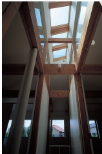
上:新築棟外観 右:天窗見上げ。窓はフィックスタイプ。換気は壁面の窓から行われる計画
