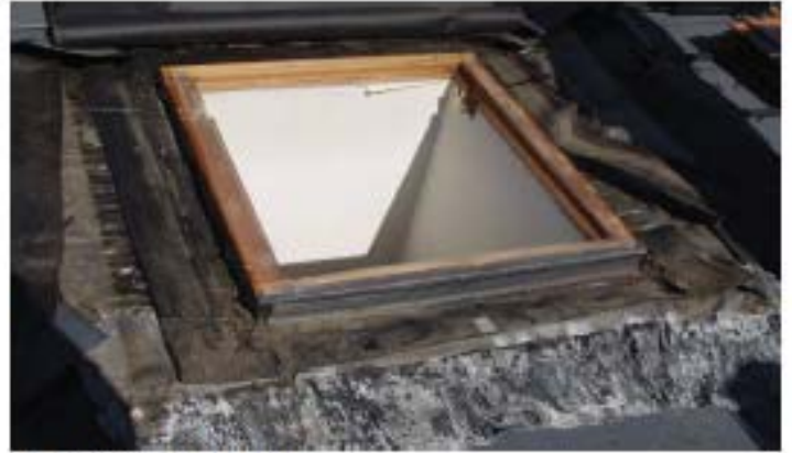
2、瓦廻りを外し、本体も取り外す
