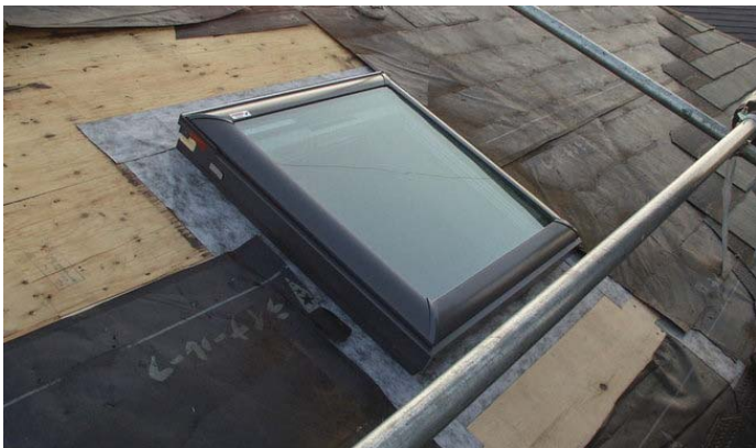
5、VS M02を設置し、防水施工を行っている状況
