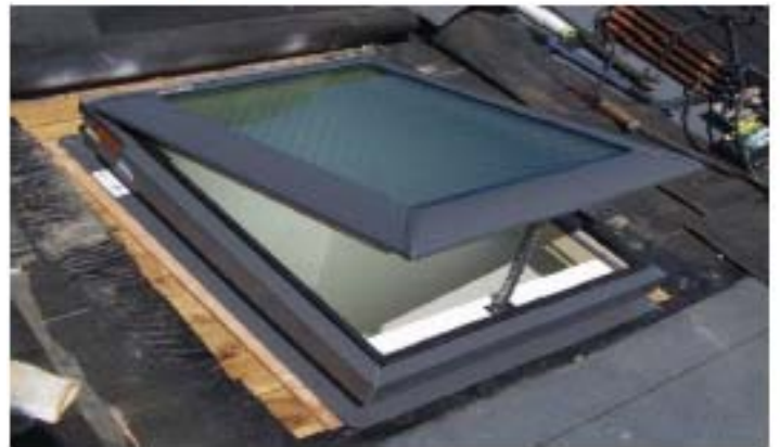
4、VS-C01を仮置きし枠納まりを確認する
