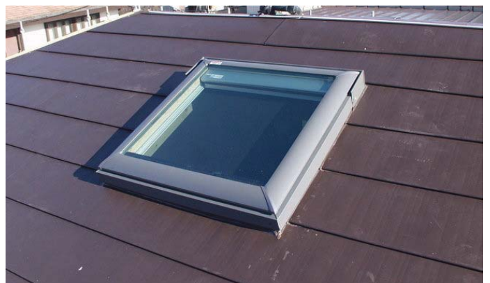
6、ガルバリウム鋼板屋根材施工後の状況
