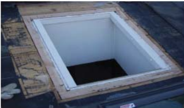
3、松下電工2025を外し、最低見付を確保した上で、開口枠上部のみの枠を取り付ける
