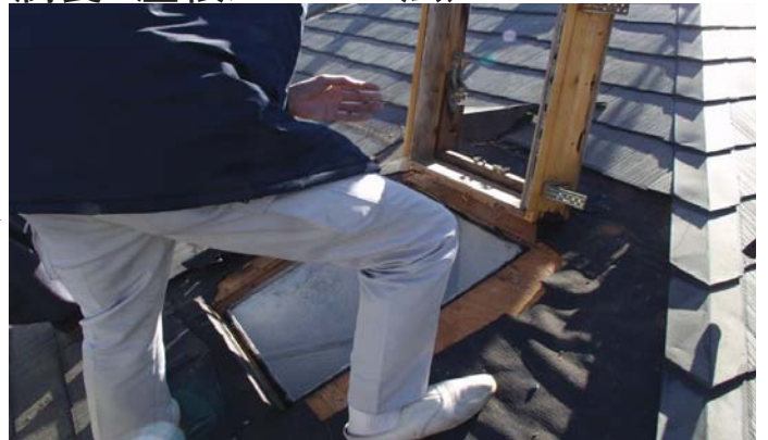
2、ルーフィングシート下のLアングルのビスを外し天窓を取る
