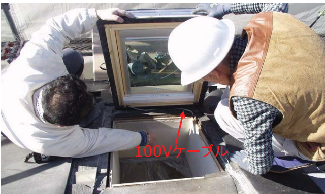
4、新規天窓の取り付け
