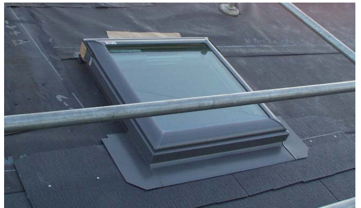
6、防水施工及び屋根材再施工
