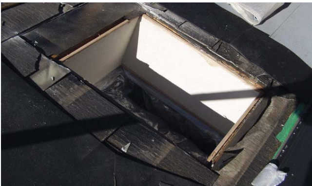
3、水切りも切り落とし、野地を整える
