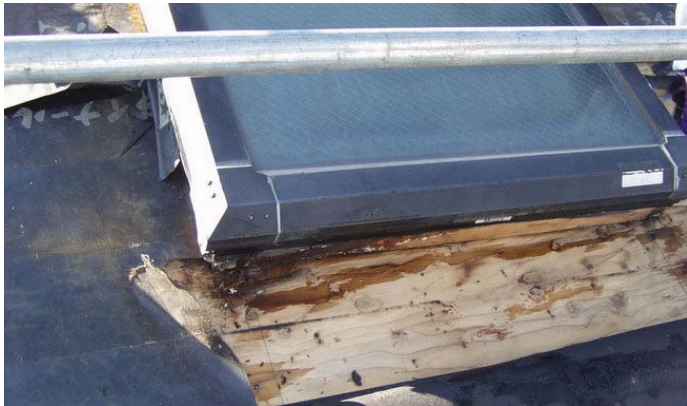
1、外部アルミカバー廻りを外していく
