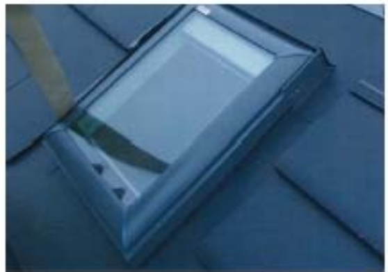
6、上部板金を施工し、カバー工法の屋根材を施工して行く
