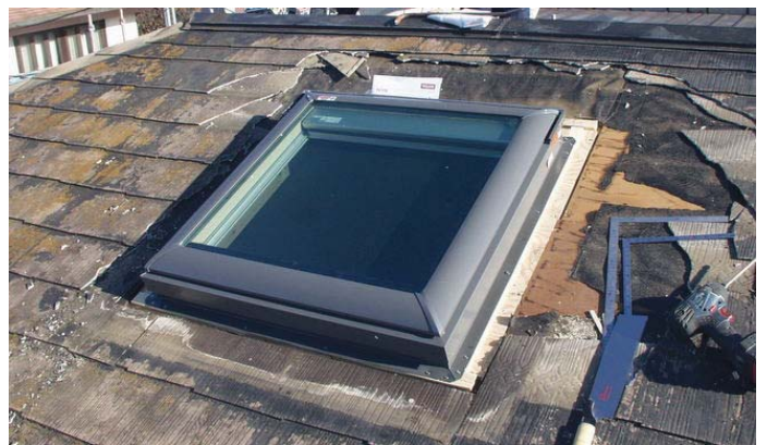
4、VS電動タイプを施工した後、防水シートを設置
