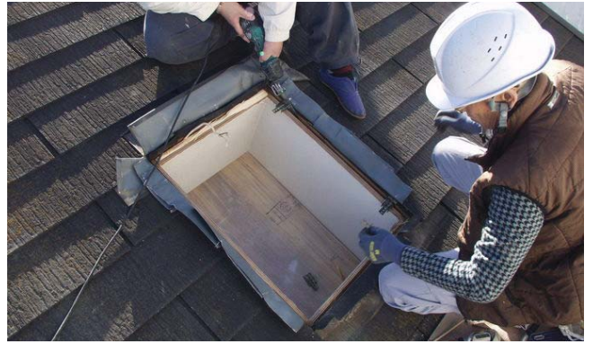
2、トップライトを外した状況、サンダーで金具を切断
