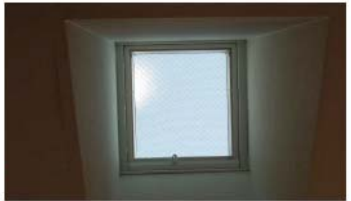
8、VS-C01施工後の内装見上げ
