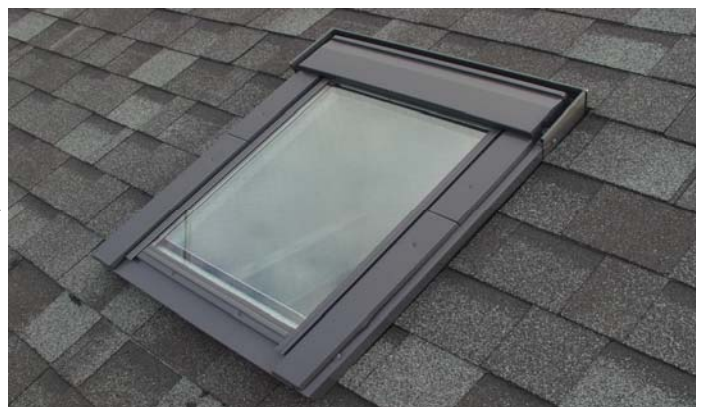
6、防水施工後、シングル材でカバー工法仕上げ
