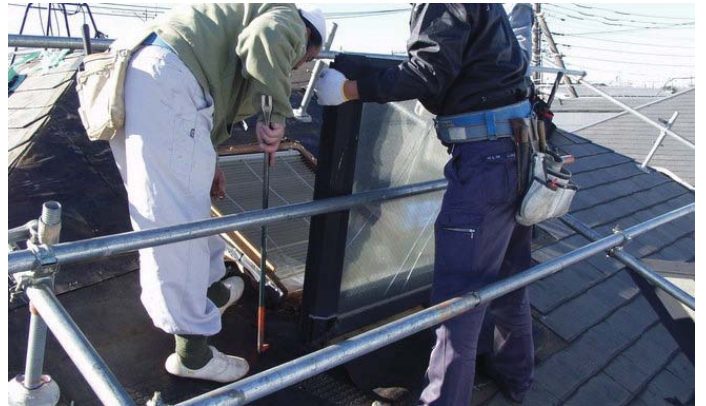
2、スレート廻りを外し、本体も取り外す
