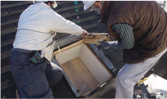
1、既存トップライトの撤去
