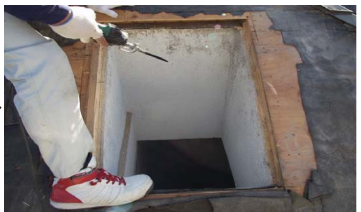
4、GGUは野地板面より5cm枠が下がる為、ジグソーなどでカット
