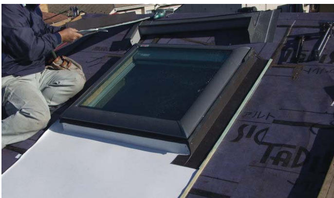
5、ルーフィング施工(p13参照)し、外部板金部材を納めていく
