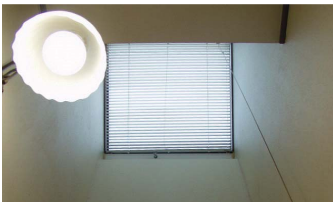
7、施工前の内装
