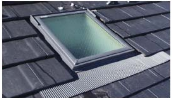
6、防水施工及び屋根材再施工
