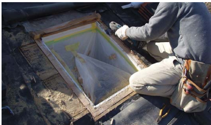
1、開口補強を屋根から調整
