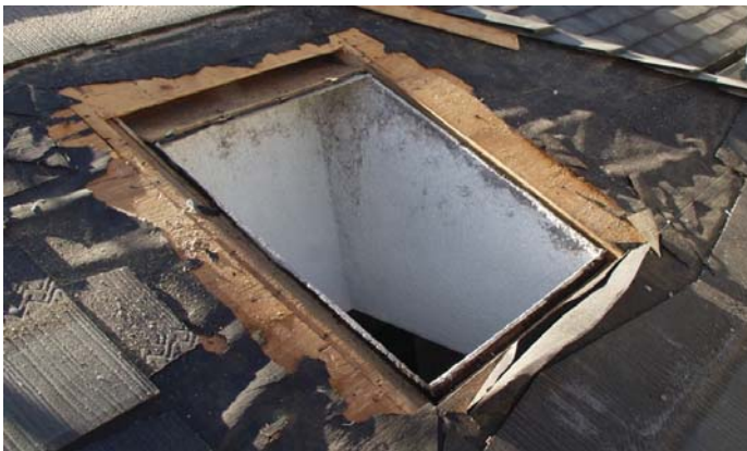
3、GGL101を外し、C02はhで大きい為、80mm開口を広げる
