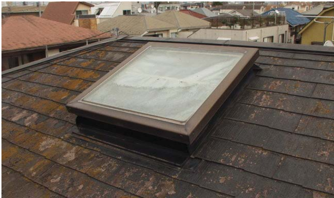
1、取り外し前の納まり状況
