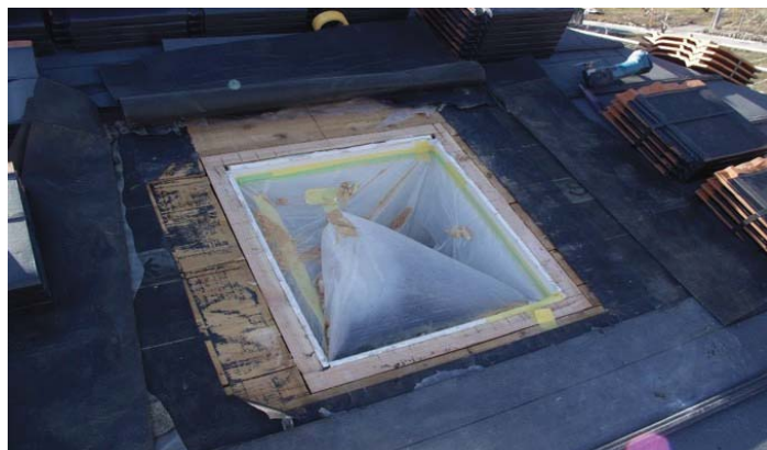
2、開口廻り野地面を平坦に仕上げる
