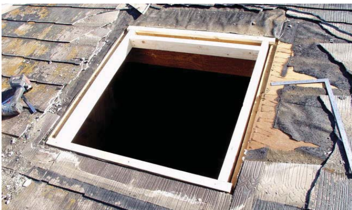
3、もう一回り開口を小さくする枠を取り付ける
