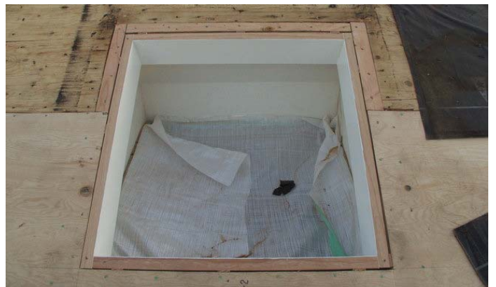
4、VSを取り付ける為の内枠取り付け
