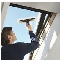
Da bi se očistilo spoljno staklo iznutra, rotirajte kriло i fiksirajte ga rezom u poziciju za čišćenje. Otvorite gornji element radi čišćenja spoljnog stakla donjem elementu.
